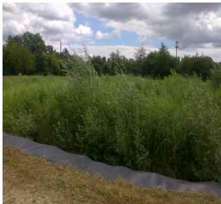
Illustration 3: Présence de saules dans le filtre (Source Photo Cerema)
