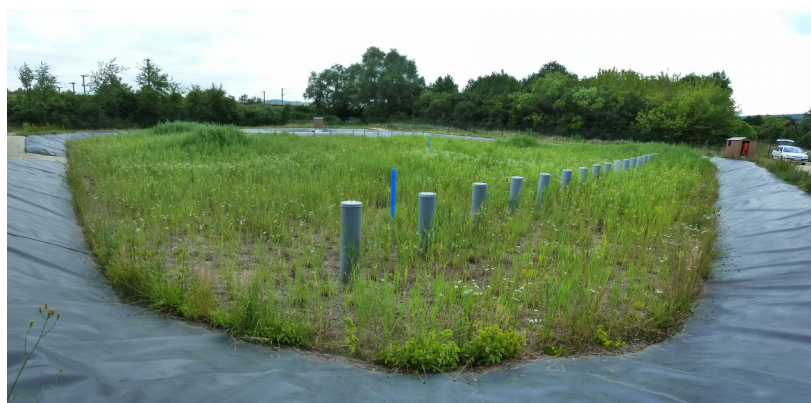
Illustration 1: Le filtre planté de Moulins les Metz (Source Cerema)
